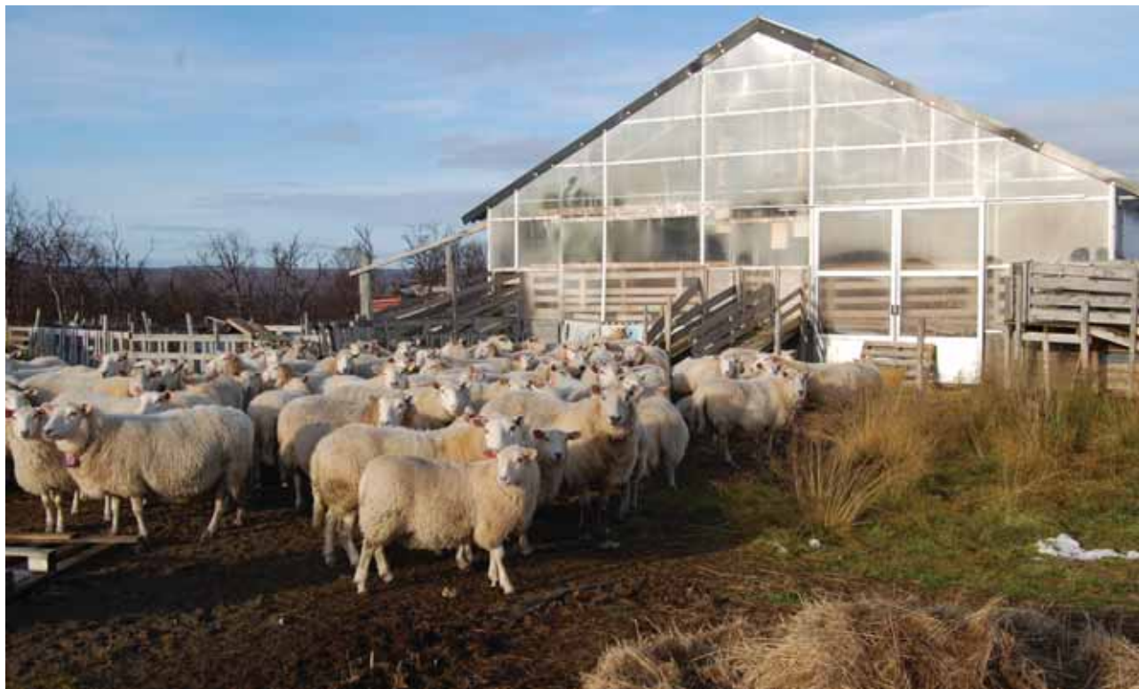
Godt fornøyd med miljøfjøset. Noe av saueflokken utenfor fjøsbygningen. Den er kledd med polykarbonatplater som lyset slipper igjennom, og ligner derfor mer på et drivhus enn et sauefjøs. (Foto: privat)
