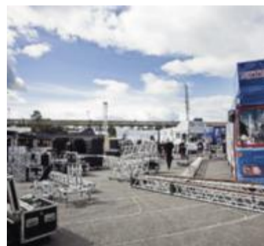
KJEMPELØFT: Tett av trailere, kraner og trucker på stadion i går.
